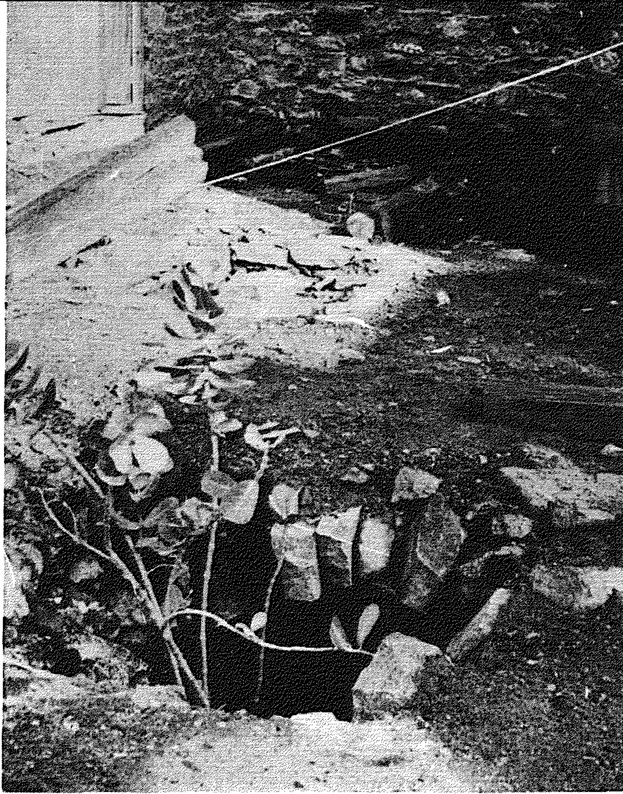
لوحة رقم (٢٦): قلعة لعلع: أسلوب تسقيف خزائن الماء الذي كشف عنه انهيار ناتج عن مياه الأمطار.
